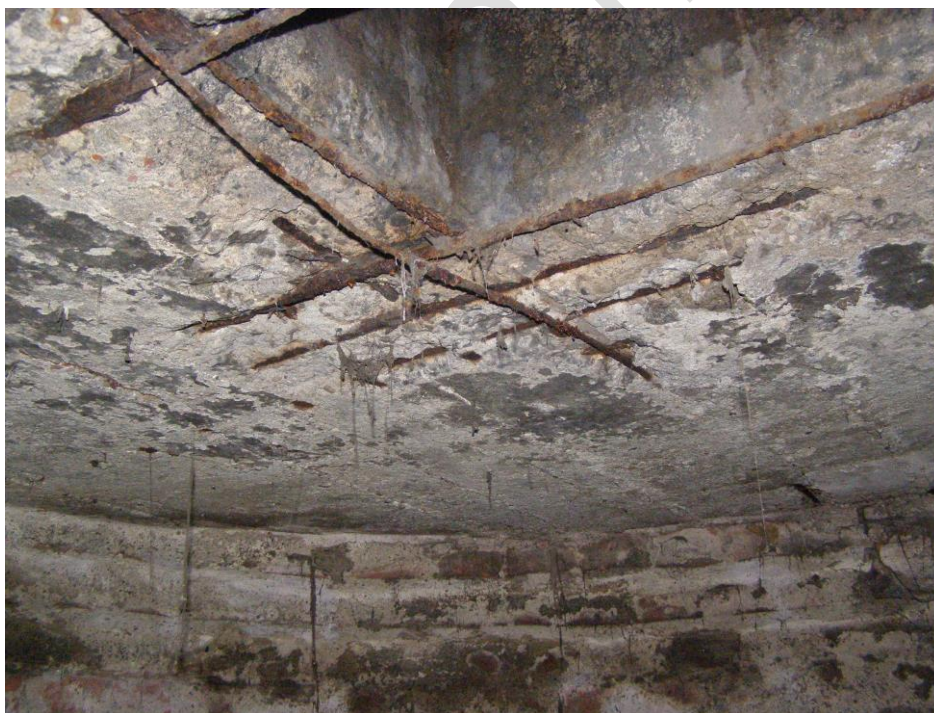
Widoczne skorodowane zbrojenie żelbetowej płyty stropowej w rejonie otworu na zrzut opału
