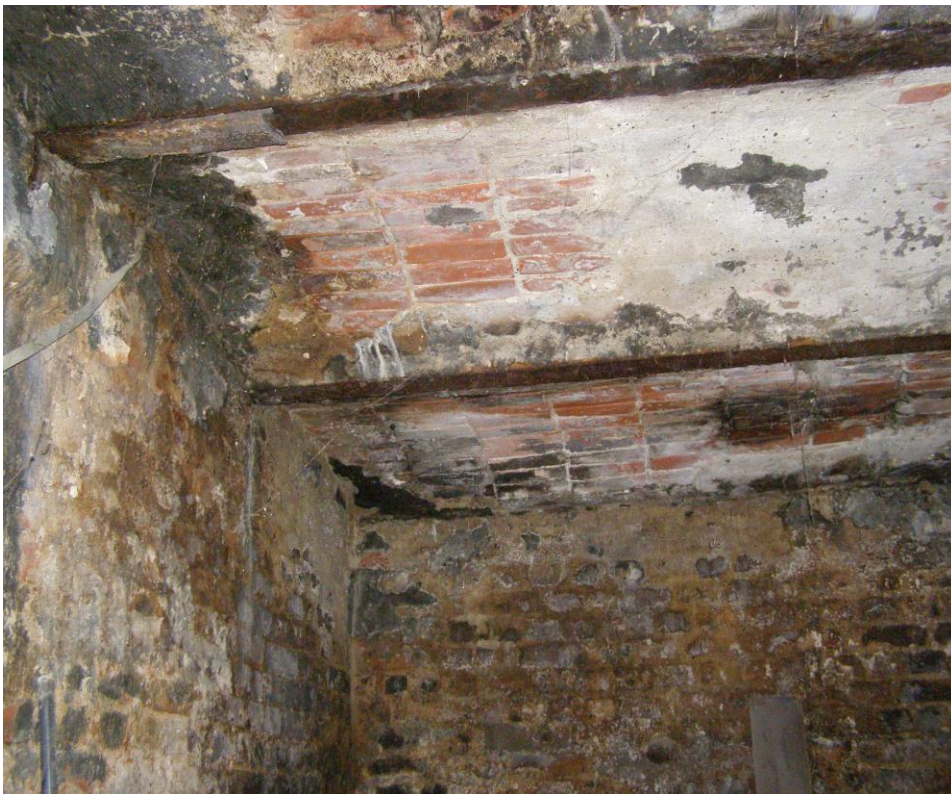
Na powyższym zdjęciu widoczne mocno skorodowane belki stalowe (szacuje się ubytek nośności na ok 50% )
